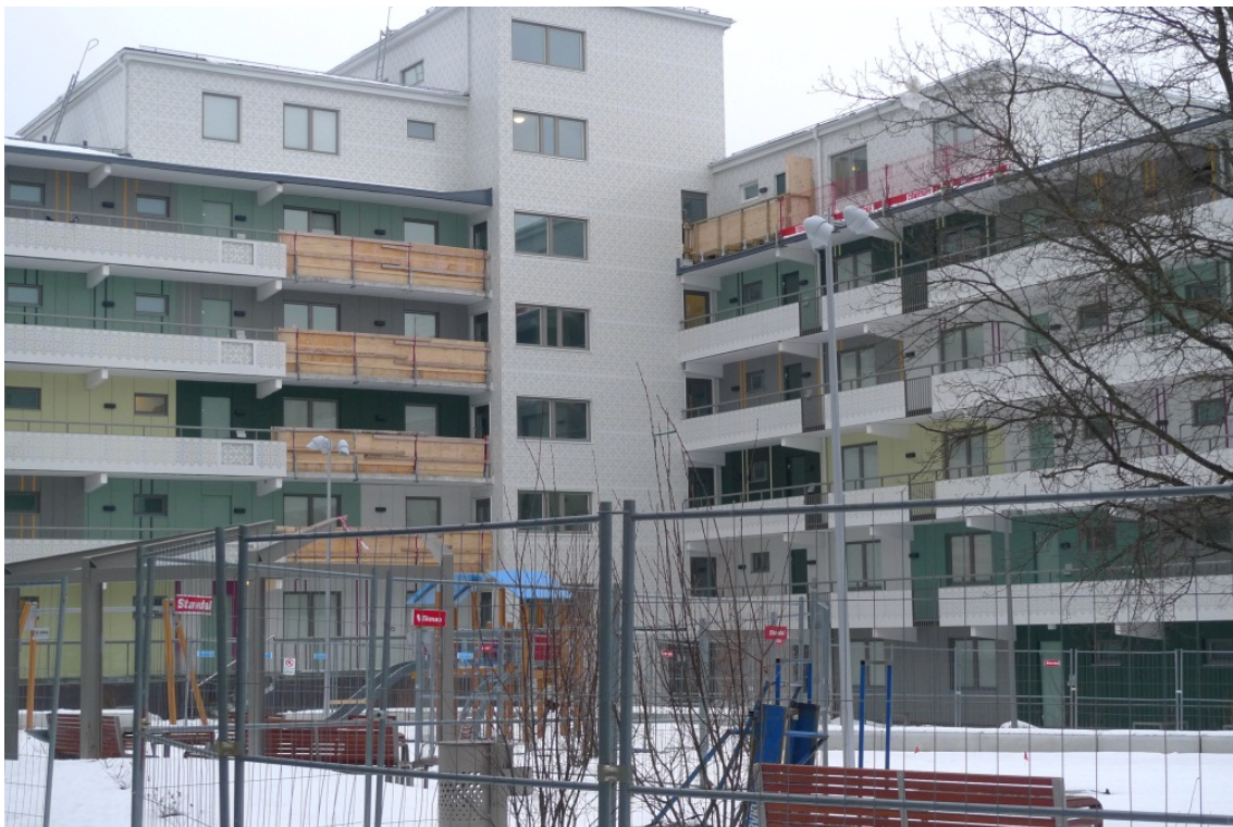
Samma byggnader/vinkel efter renovering.
