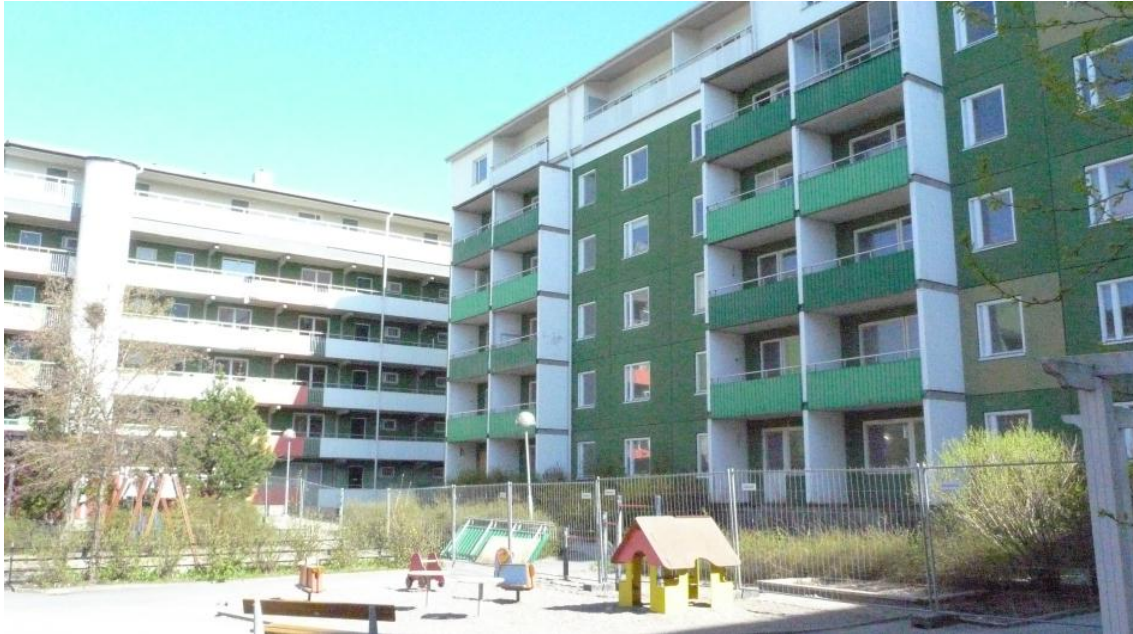
Trondheimsgatan, Husby, före renovering.
