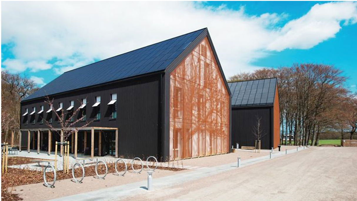
Skanskas kontor i Helsingborg belönades med årets solenergipris 2012. Källa: Skanska
