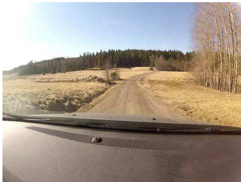
Figur 56: Mätpunkt 2 Teststräckan på Edanehalvön öster om Arvika. 4 Apr. Ytan är lätt uppmjukad. Låg spårbildning.
