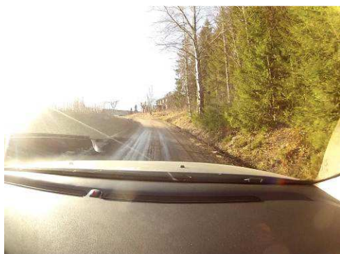
Figur 60: Mät punkt 5 Teststräckan på Edanehalvön öster om Arvika. 14 Mars. Uppmjukat, med spårbildning.
