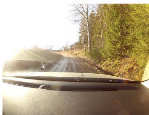
Figur 44: Mätpunkt 5 Teststräckan på Edanehalvön öster om Arvika. 14 Mars. Uppmjukat, med spårbildning.
