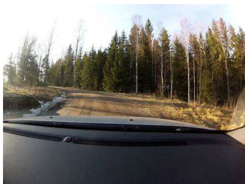
Figur 62: Mät punkt 7 Teststräckan på Edanehalvön öster om Arvika. 14 Mars. Ytuppmjukat, lite till ingen spårbildning.
