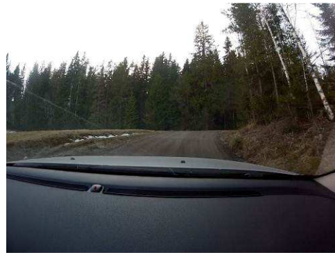
Figur 57: Mätpunkt 3 Teststräckan på Edanehalvön öster om Arvika. 14 Mars. Uppmjukad yta, låg spårbildning.
