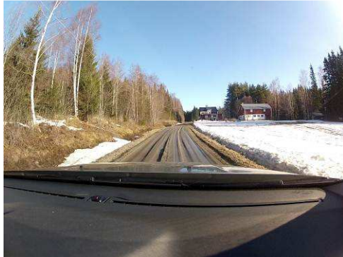
Figur 54: Exempel på en väg med hög spårighet norr om Kramfors.
