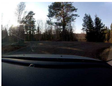
Figur 63: Mät punkt 8 Teststräckan på Edanehalvön öster om Arvika. 14 Mars. Upptorkat i ytan, ingen spårbildning.
