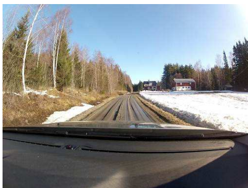
Figur 40: Exempel på en väg med hög spårighet norr om Kramfors.
