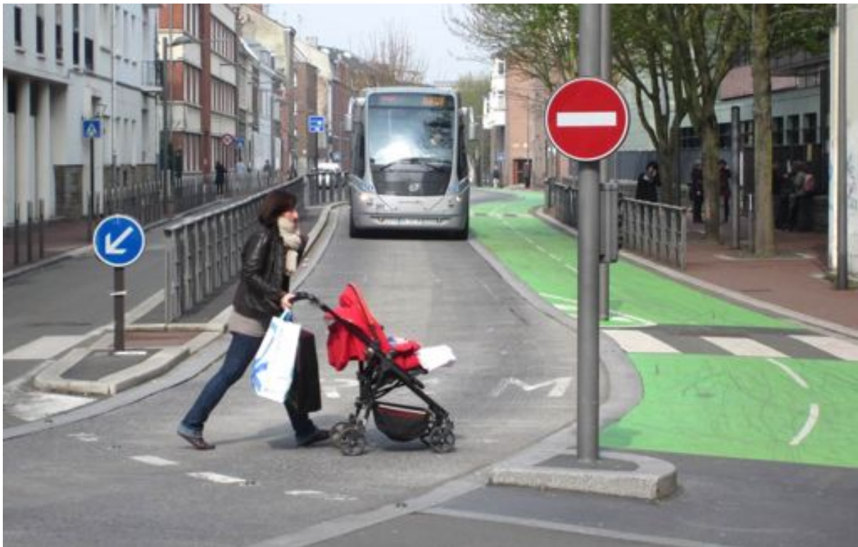
Figur Gatu-utformning i Douai med körbana för bilar, BRT, cykel och gångtrafik. Som synes använder man beläggning med unik färg för olika trafikslag. Kollektivtrafiken och biltrafiken går enkelriktat åt varsitt håll på denna stadsgata. (Foto: Karl Kottenhoff)
