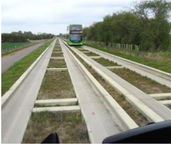
Figur Bussbana med betongspår utanför Camebridge. Linjen går till mindre orter som ligger utefter denna före detta järnvägsbanvall. (foto Kottenhoff)
