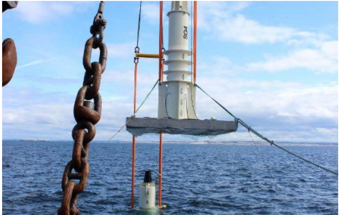
Figur 2. Sjösetting av vågkraftverk i Sotenäsprojektet etapp I, juli 2014. Bild från www.seabased.com , åtkomst senast kontrollerad 2014-11-11.
